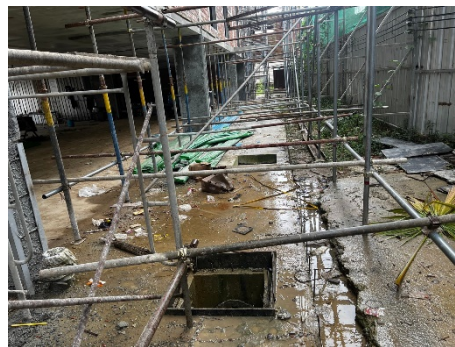
รูปที่ 3.2-10 ท่อระบายน้ำ และบ่อพักน้ำภายในพื้นที่ก่อสร้าง
