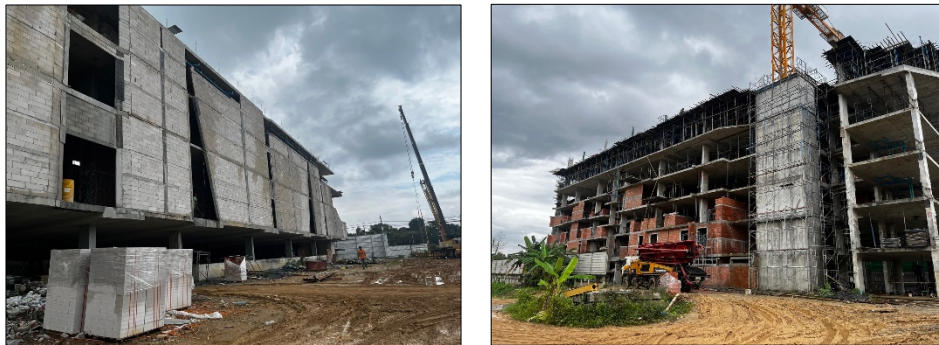
รูปที่ 3.2-6 การก่อผนังอาคารเพื่อใช้สำหรับกันเสียงช่วงตกแต่ง
