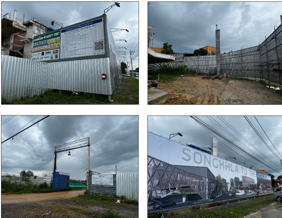
รูปที่ 3.2-1 การจัดทำรั้วและประตูด้านหน้าพื้นที่ก่อสร้าง พร้อมการติดตั้งป้ายเตือน ป้ายประกาศ ระบุชื่อ-ที่อยู่ หมายเลขโทรศัพท์ ที่สามารถติดต่อได้
