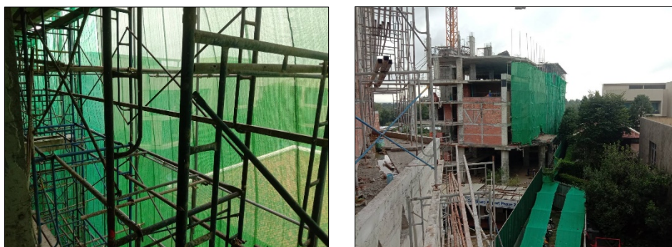
รูปที่ 3.2-2 การติดตั้งตาข่ายกรองแสง (Shading Net) หรือสแลนสีเขียว บริเวณอาคารที่กำลังก่อสร้าง
